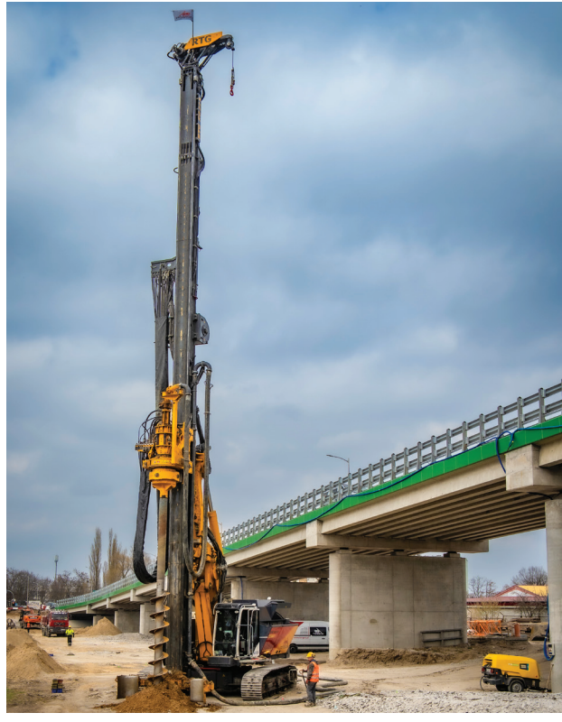
Odbudowa drugiej nitki wiaduktu na ul. Zjednoczenia przebiega zgodnie z planem. Właśnie trwają roboty budowlane związane z wykonaniem pali fundamentowych. FOT. BARTOSZ MIROSLAWSKI
