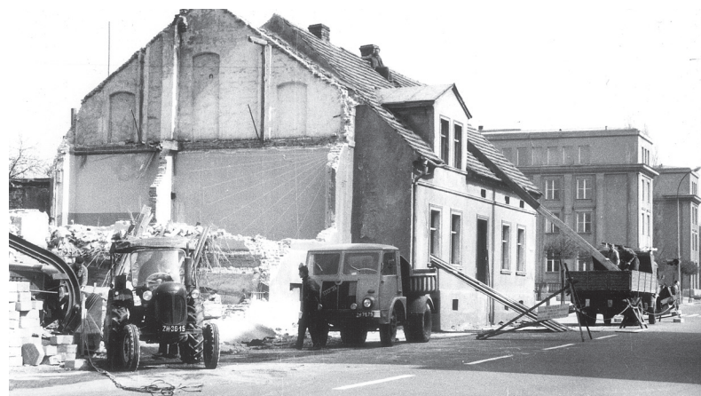
W kwietniu 1968 r. rozpoczęto burzenie starych kamieniczek FOT. BRONISŁAW BUGIEL
