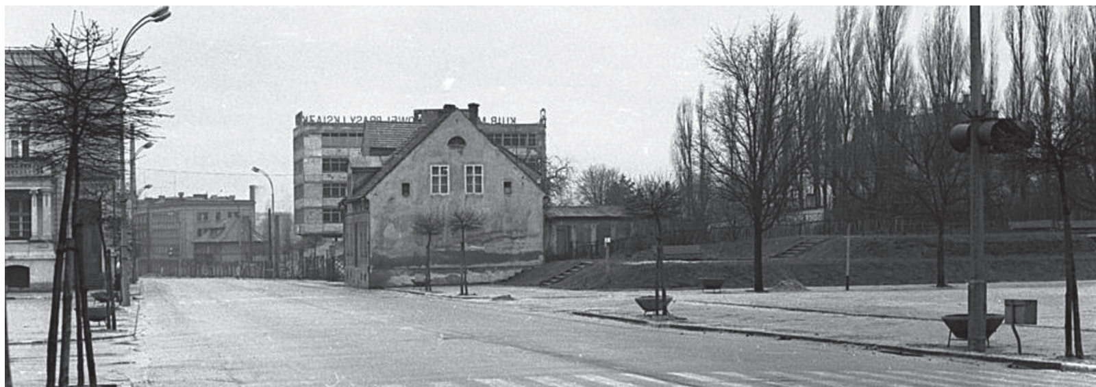
Widok ul. Bohaterów Westerplatte. Trwa budowa Klubu Międzynarodowej Prasy i Książki Ruch. Neon na budynku zamontowano w 1967 r. zanim obiekt był gotowy. FOT. BRONISŁAW BUGIEL
