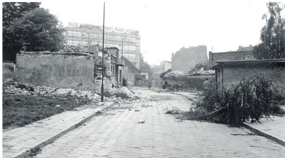
Trwa burzenie domów wzdłuż ul. Warskiego FOT. BRONISŁAW BUGIEL
