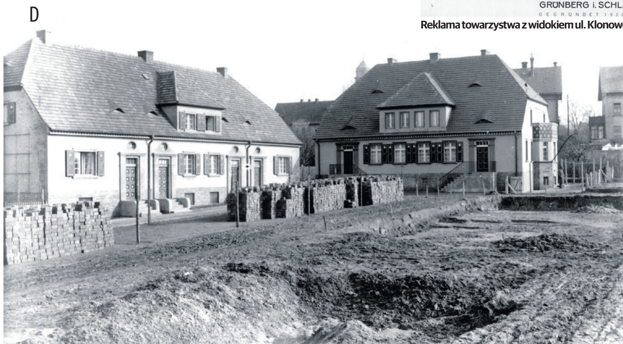
Trwa budowa domów przy ul. Klonowej
