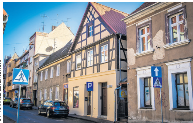
Ul. Drzewna 17 - po odsłonięciu tynku ukazała się piękna konstrukcja szachulcowa, którą odpowiednio wyeksponowano FOT. BARTOSZ MIROŚLAWSKI
