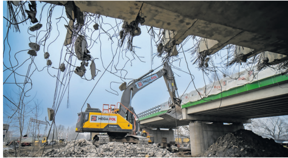
Właśnie wyburzono przeszło między ulicą Dąbrowskiego a torami kolejowymi
