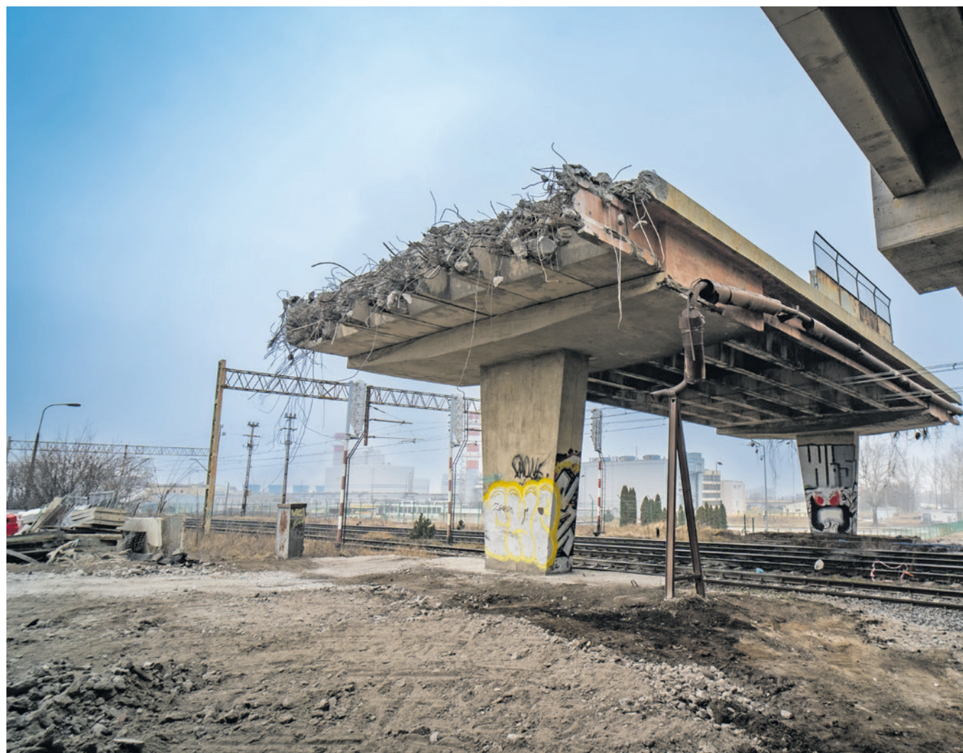
(rk) Elementy wiaduktu nad siecią zostaną zdjęte w całości przy pomocy dźwigów
