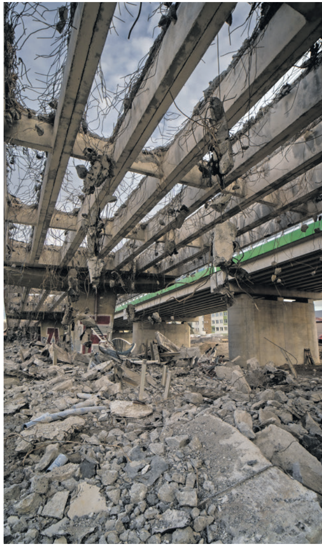
Jeszcze dwa miesiące temu stała tutaj cała żelbetonowa konstrukcja - grudzień 2024 r.
