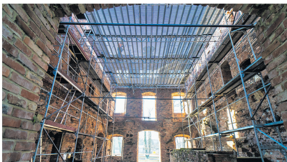
Trwają prace przy zadaszeniu pałacu w Zatoniu
