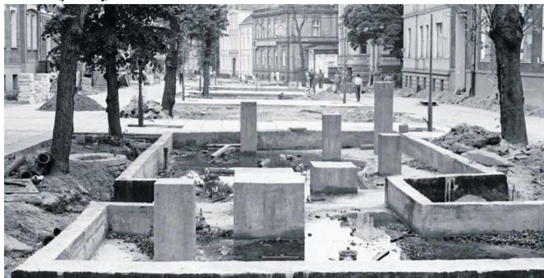
Lato 1979 r. Budowa deptaka na al. Niepodległości. Na pierwszym planie fontanna.
