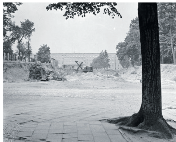
Lato 1966 r. Trwają prace przy wykopie. Widok od strony ul. Bankowej. W tle gmach Prezydium WRN, dzisiaj urząd marszałkowski.
