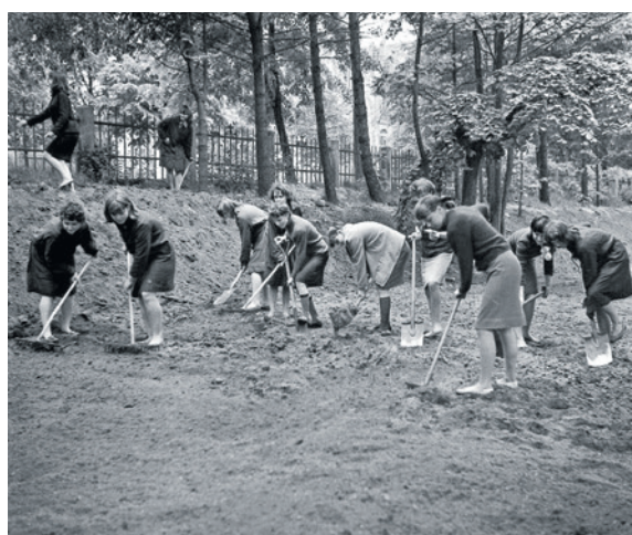
Czerwiec 1966 r. W parku pracują uczennice szkoły zawodowej Polskiej Wełny.
