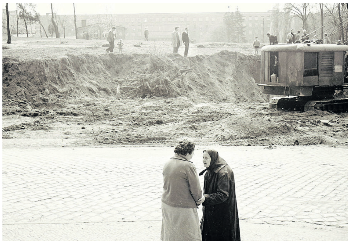
Maj 1966 r. - Niepokój budzi zabezpieczenie terenu robót. Wykop jest nieogrodzony liną. Gapie, których nie brakuje, stają na krawędzi wykopu. Najwięcej jest ich w tym miejscu, w którym właśnie koparka nabiera ziemię. O wypadek nietrudno - alarmowała „Gazeta Zielonogórska”.
