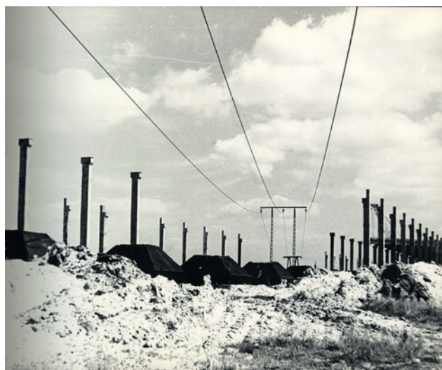
Lipiec 1974 r. Stoją już filary przyszłych hal. W kontynuacji budowy przeskądza linia wysokiego napięcia, której jeszcze nie zdemontowano. Z ARCHIWUM NOVITY
