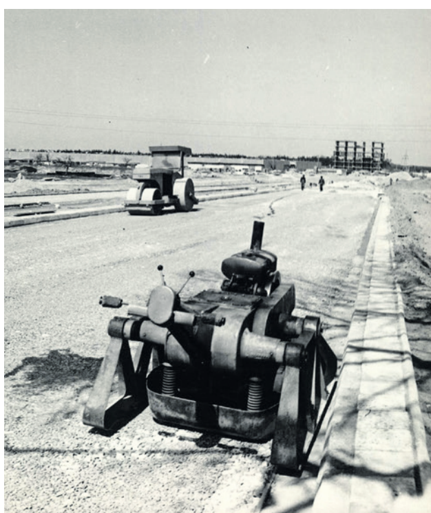
Budowa ul. Dekoracyjnej, w tle widać szkielet biurowca fabryki Z ARCHIWUM NOVITY
