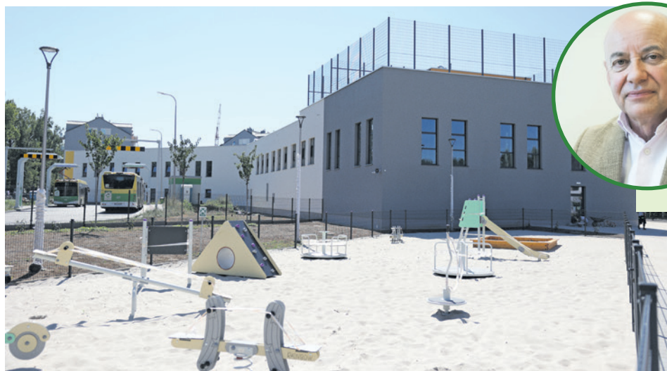
Nowa szkoła, z osobnymi wejściami do części szkolnej i przedszkolnej, znajduje się przy ul. Architektów
