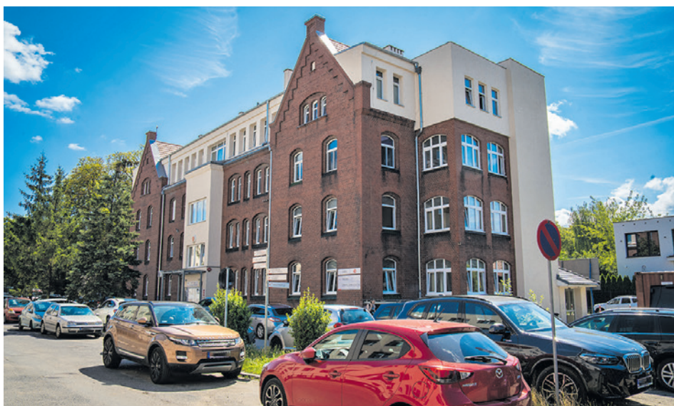
Najpierw remont, a po nim do opuszczonego przez otolaryngologię budynku z czerwonej cegły wprowadzi się szpitalna administracja
