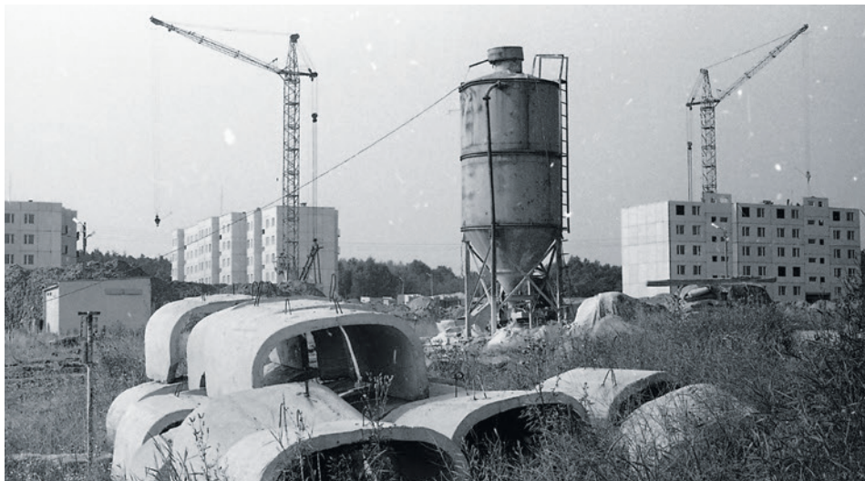
Kisielińska Dzielnica Mieszkaniowa - ogólny widok na plac budowy
