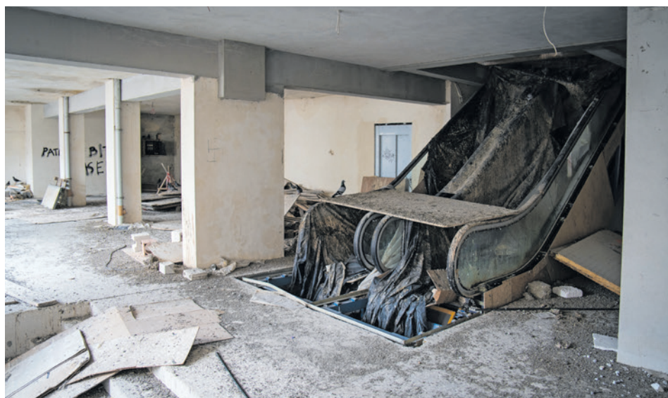
W budynku czuć fetor – wszędzie są ptasie odchody
