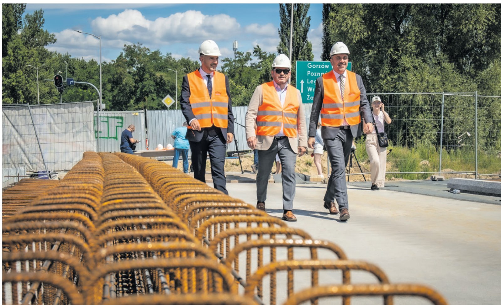
Prezydent Marcin Pabierowski, prezes Nowak-Mosty Władysław Nowak i wiceprezydent Paweł Tonder na remontowanej nitce wiaduktu. Jesienią zostanie tutaj przywrócony ruch samochodów. Wtedy rozpocznie się burzenie sąsiedniej, starej nitki wiaduktu.
